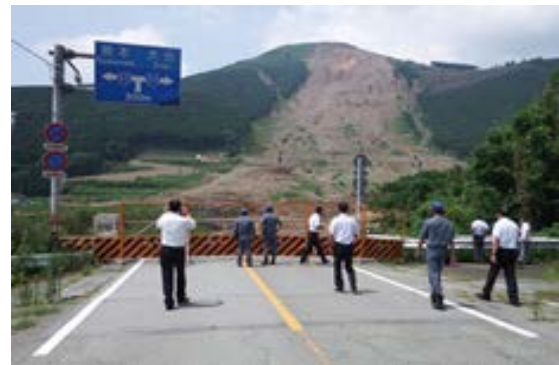
阿蘇大橋災害現場
