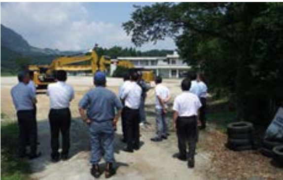
黒川地区災害現場
